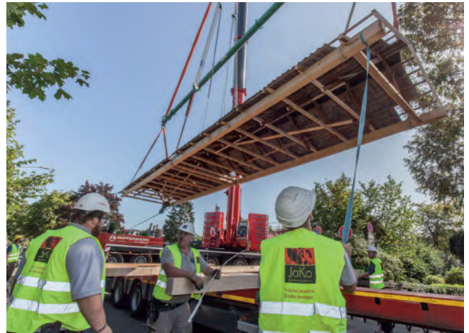
Anheben des Dach- und Gebäudeelements mit Strahltraversen.
