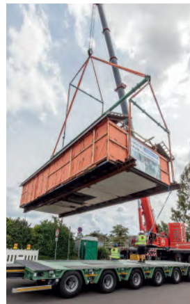
Gebäudeelement auf dem Transportfahrzeug gesichert.
