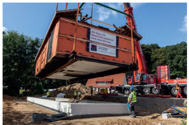
Wiederaufbau des Gebäudeelements auf dem rekonstruierten Keller.
