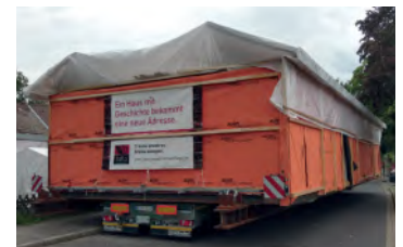
Gebäudeelement auf dem Transportfahrzeug gesichert.
