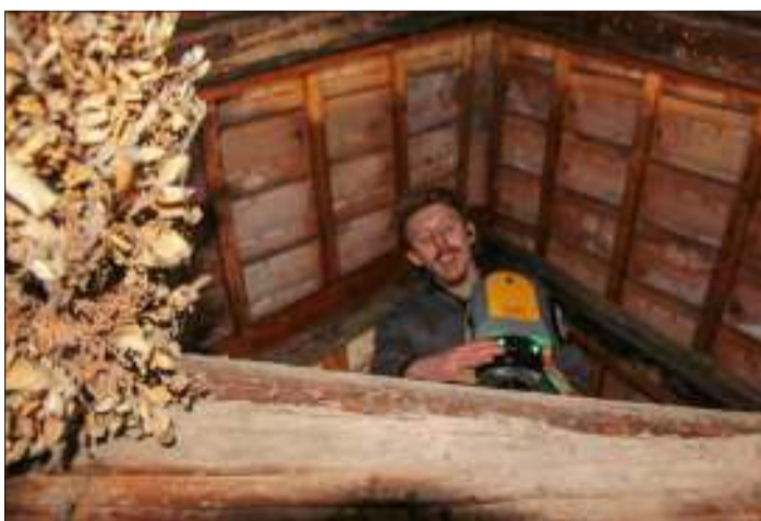
In Durbach starten am 27. September 2021 die Vermessungen, Dokumentationen und Vorbereitungen für die anstehenden Arbeitsschritte.
