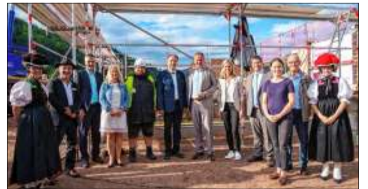
Zur feierlichen Grundsteinlegung kommen zahlreiche Gäste, darunter auch Vertreter des Landratsamts und des Regierungspräsidiums sowie die Bürgermeister der umliegenden Gemeinden.
