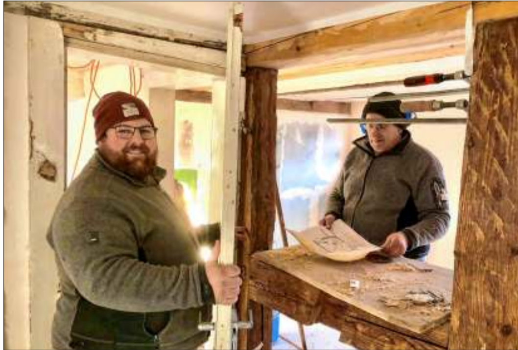
Jochen Christ (links) ist der Kapo der Baustelle Ortenauhaus im Freilichtmuseum Vogtsbauernhof. Sein Kollege Klaus Hengge ist schon seit 44 Jahren bei JaKo und einer der erfahrendsten „Translozierer“.
