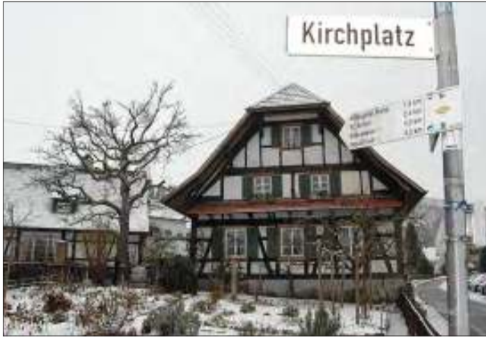
Die Erstbesichtigung: Auf Einladung der Familie Bächle in Durbach ist die Museumsleitung zum ersten Mal vor Ort, um sich das Gebäude am „Kirchplatz 6“ anzusehen.
