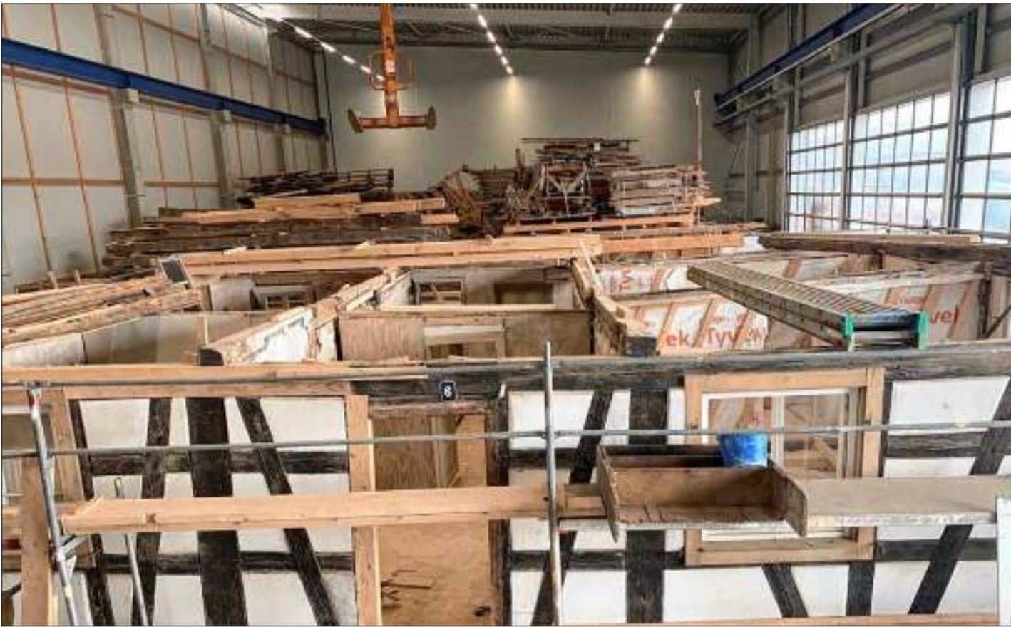
Arbeit im Warmen und im Trockenen: In der Halle der JaKo Baudenkmalpflege wurde das Haus Stück um Stück saniert.
