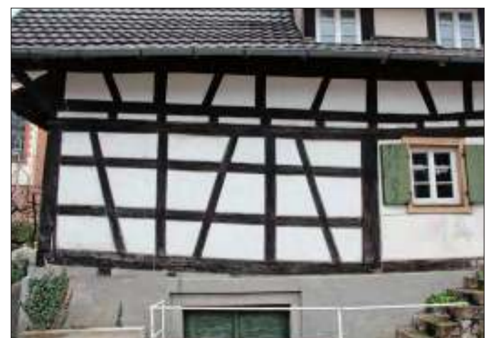
Vor der Translozierung: Das schräg verlaufende Schwellenholz verheißt einiges an Arbeit.
