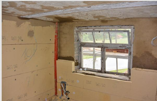
**Abb. 6.30:** Innenansicht des denkmalgeschützten Gebäudes mit Innendämmung aus Holzfaserplatten mit weiterem Aufbau mit Lehm
