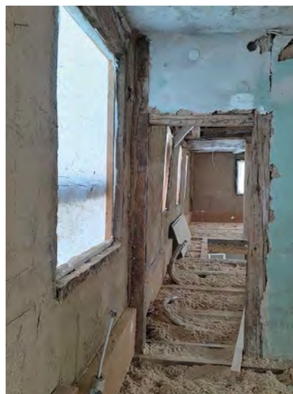
Abb. 4: Ertüchtigung der Außenwand von innen
