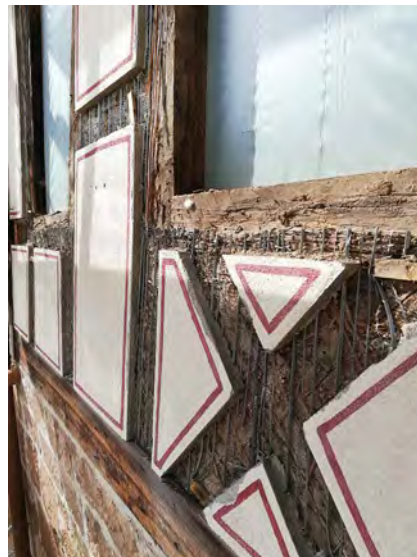
Abb. 3: Freilegung der alten Fachwerkwand
