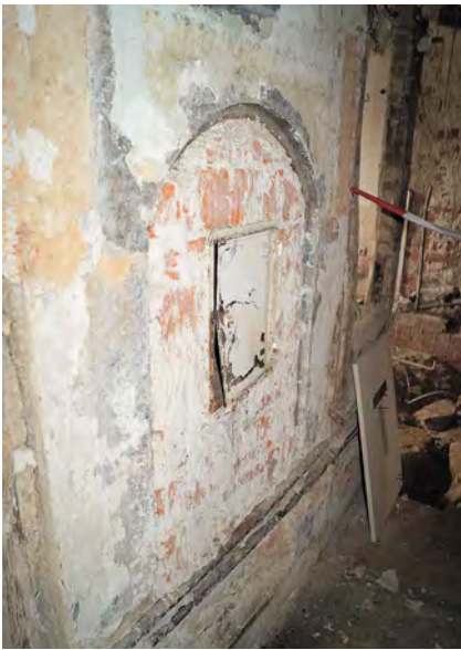
Abb. 10: Ofen im Erdgeschoss aus Bauphase III
