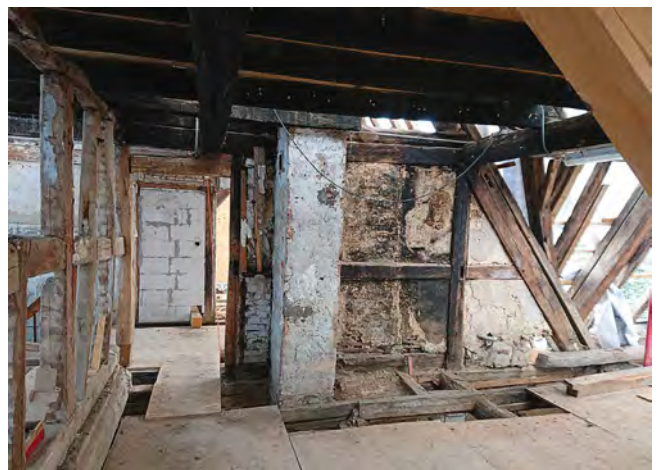
Abb. 2: Verrußte Dachkonstruktion
