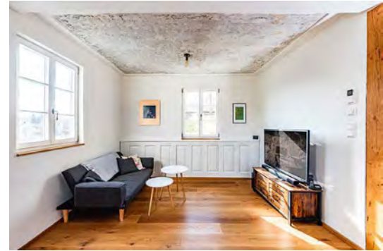
Abb. 13: Restaurierte Lamperien und Deckenfries mit sichtbaren Farbschichten
