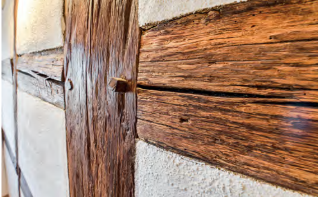
Altes Fachwerk neu restauriert.
