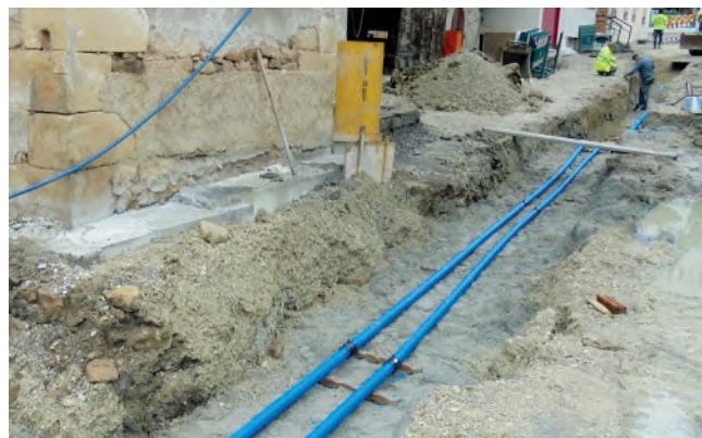
Verlegung der Soleleitungen
