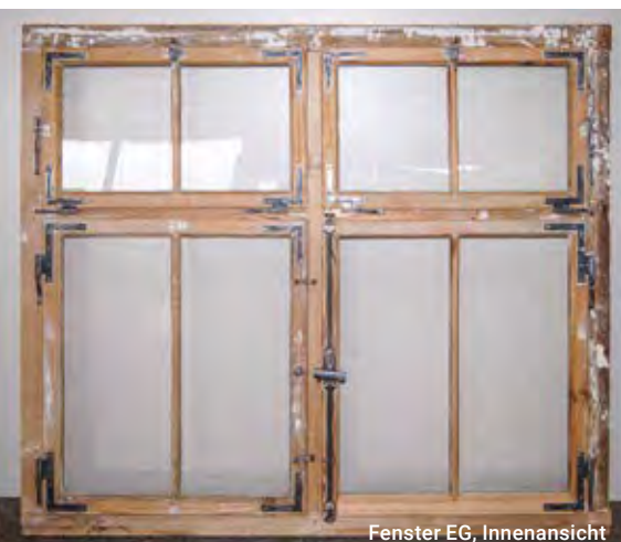
Fenster EG, Innenansicht
