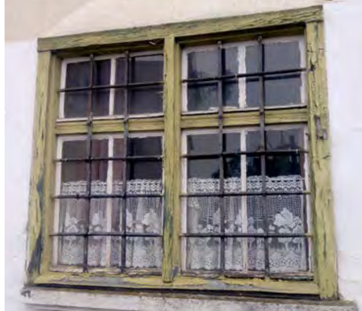
Abb. 3 Außenansicht eines Eichenfensters, Erdgeschoss
