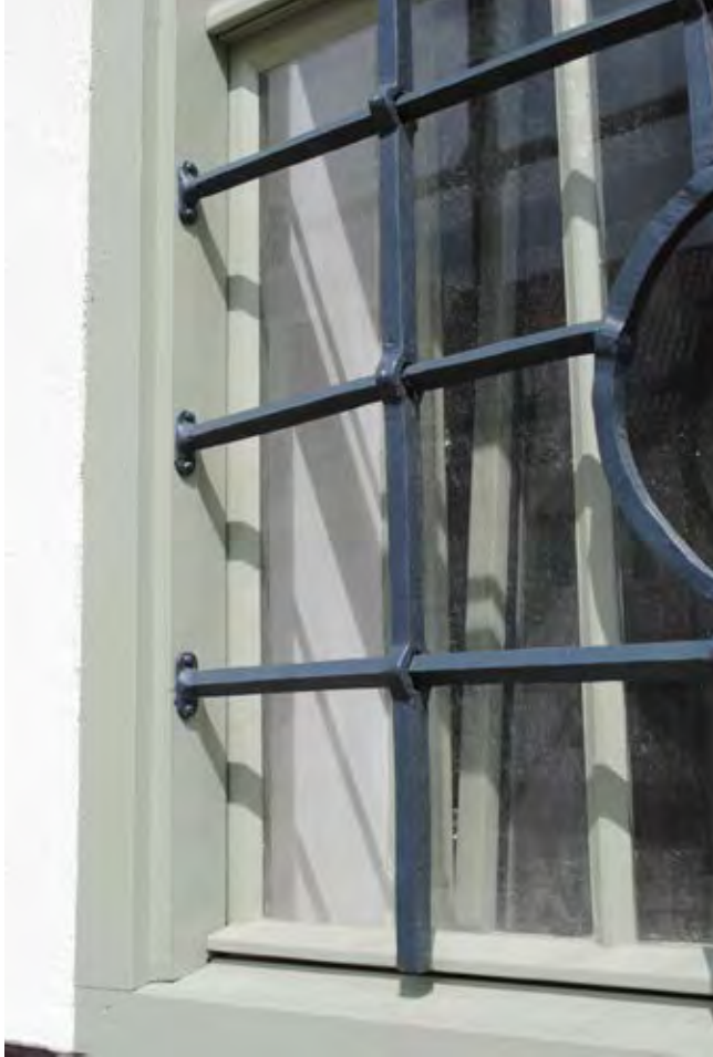
Abb. 19 Detailansicht, eingebautes Fenster, Erdgeschoss
