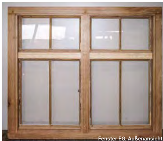
Fenster EG, Außenansicht
