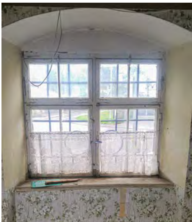
Abb. 2 Innenansicht eines Eichenfensters, Erdgeschoss
